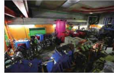
理研重イオン線形加速器 RILAC2 (高安定、高加速効率を実現するために開発された。紫色の空洞はイオン源からのイオンビームを加速している)
